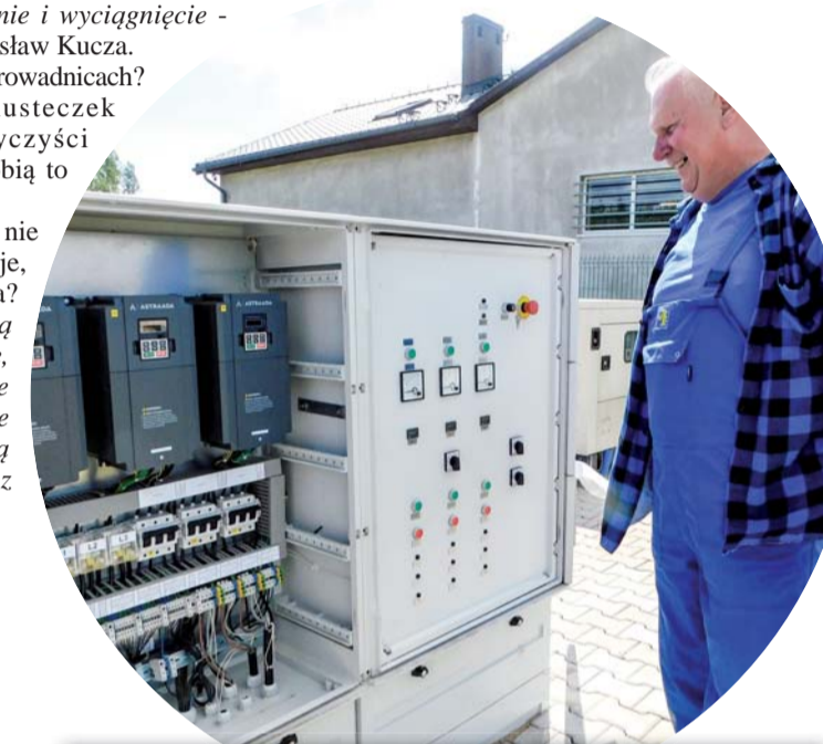
▲ - Przepompownia przy ulicy Zachodniej jest sterowana automatycznie - tłumaczy brygadista Mirosław Kucza.
